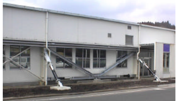
図8 制振改修の使用例（水平および斜めで使用）
