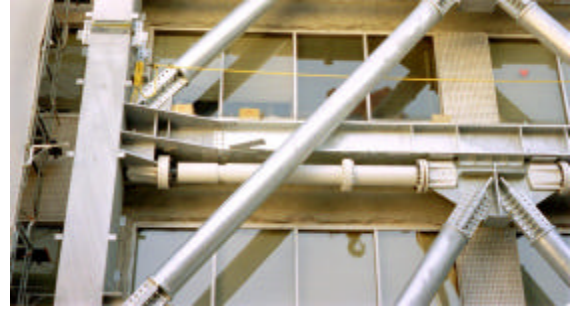
図7 耐震補強の使用例（水平な白い円筒がRDT）
