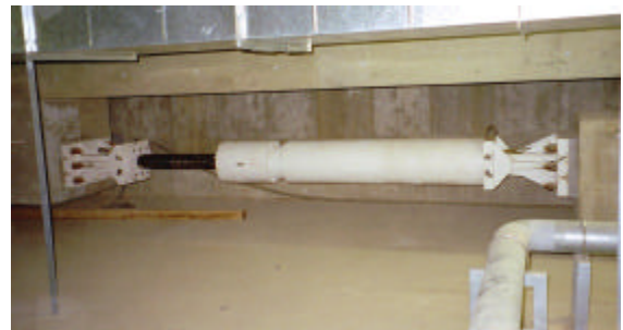
図10 RC造免震建物のダンパー使用例
